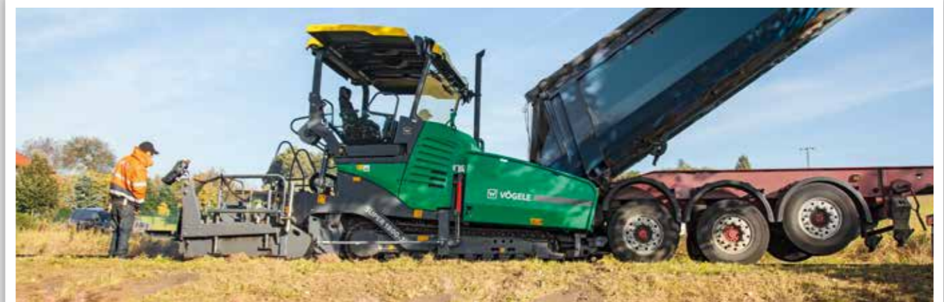
EINSATZ ALS KLASSISCHER STRASSENFERTIGER
