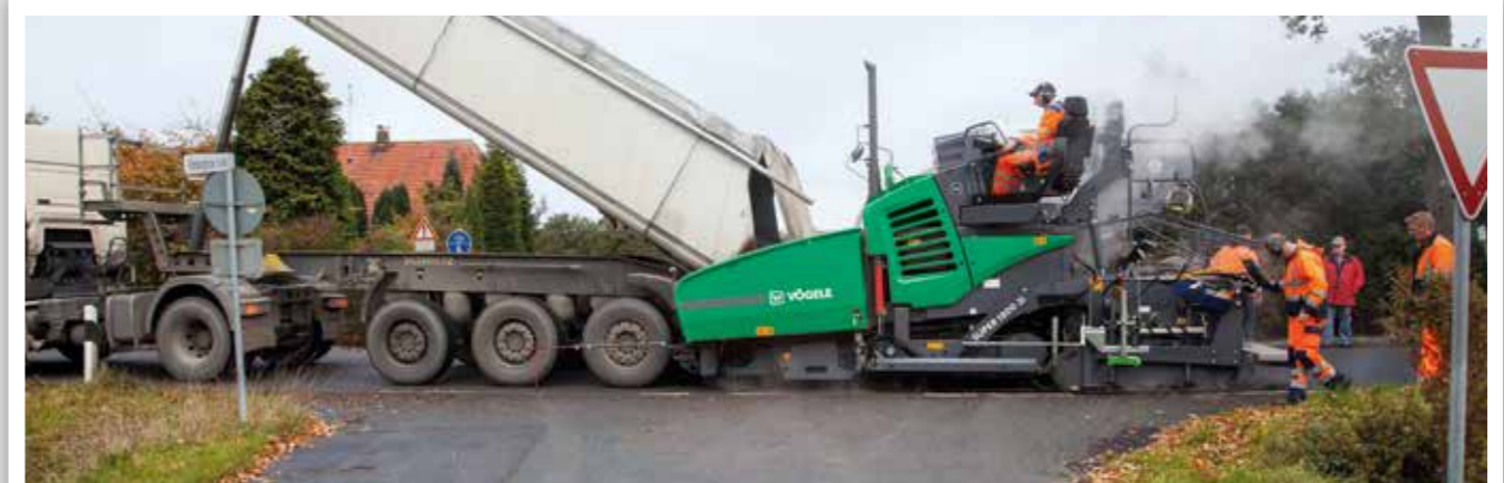
SANIERUNG IN EINEM WOHNGEBIET
