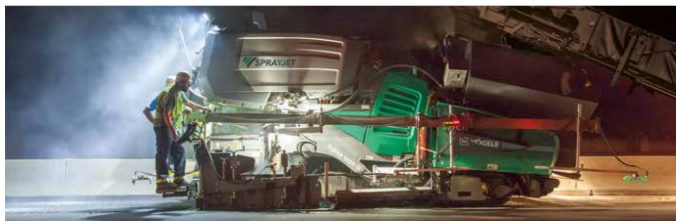
SANIERUNG EINER AUTOBAHN
