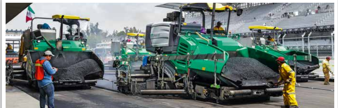
SANIERUNG EINER RENNSTRECKE
