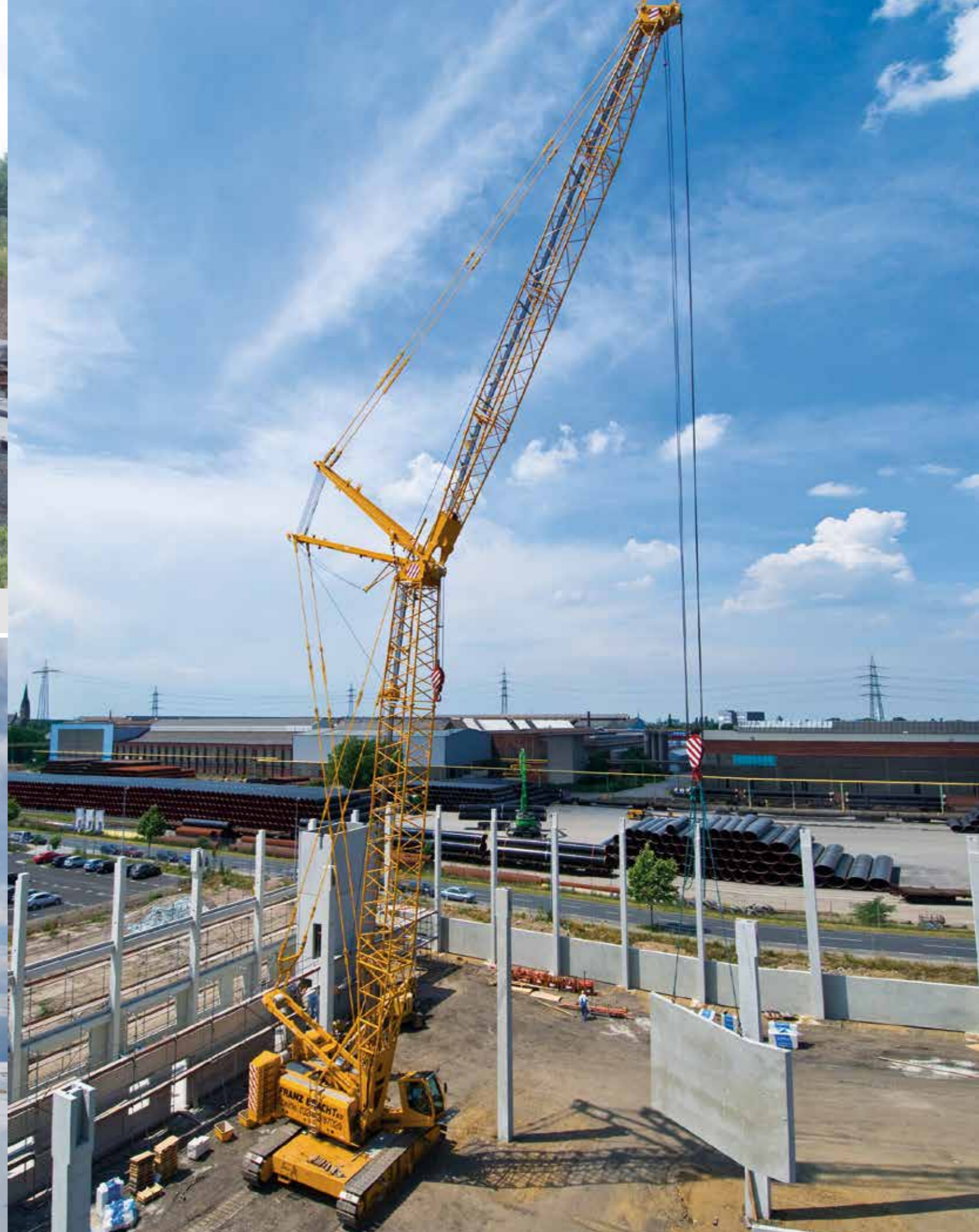
4400 – Concrete-prefabricated parts installation; Germany 4400 – Beton-Fertigteilmontage; Deutschland
