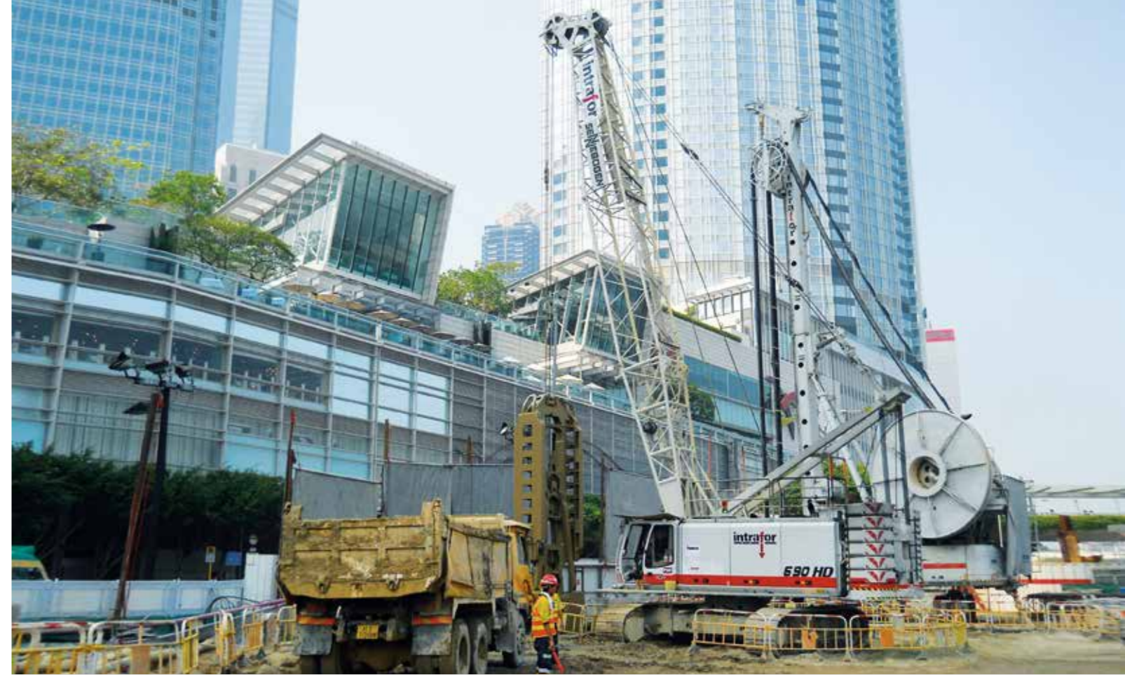
690 HD - With mechanical diaphragm wall grab; Hong Kong 690 HD - Mit mechanischem Schlitzwandgreifer; Hong Kong
