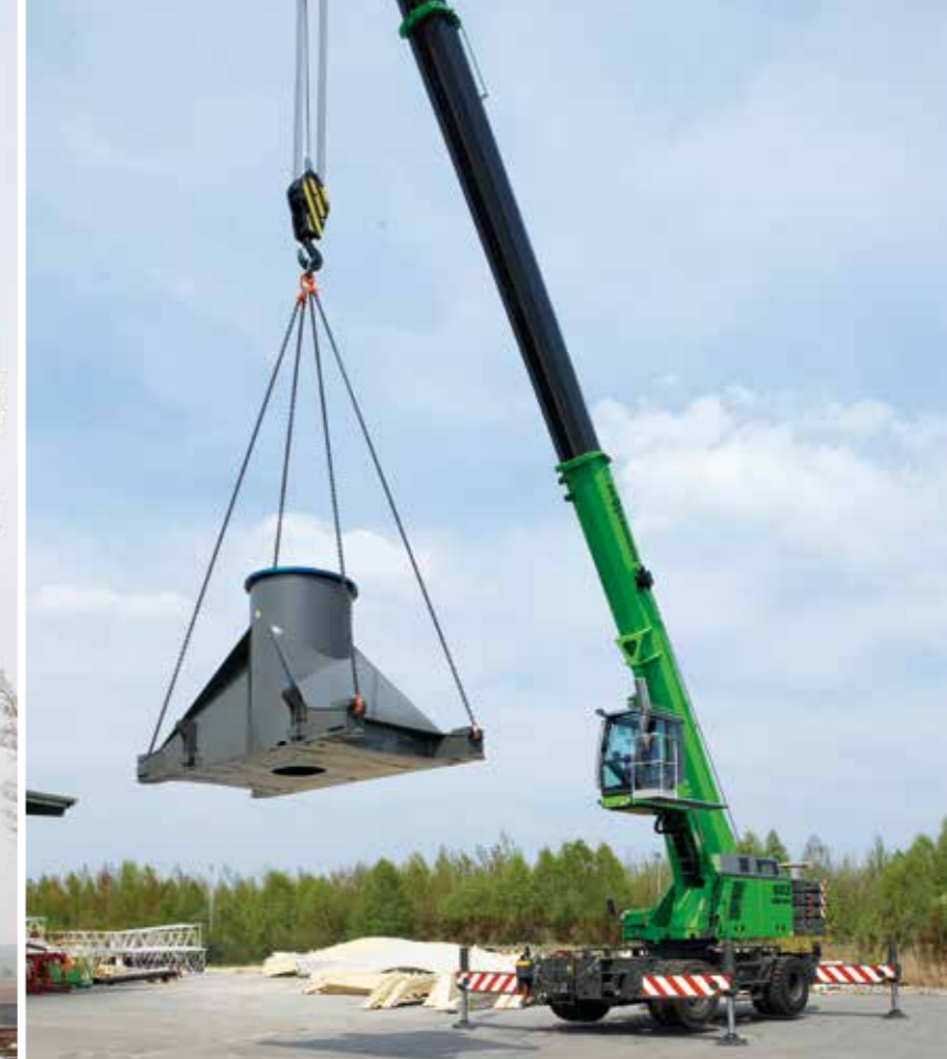
683 M – Yard crane works; Germany 683 M – Lagerplatz-Hebearbeiten; Deutschland
