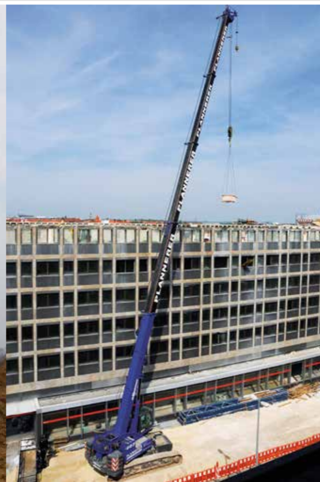
683 R – Deconstruction works; Germany 683 R – Rückbauarbeiten; Deutschland
