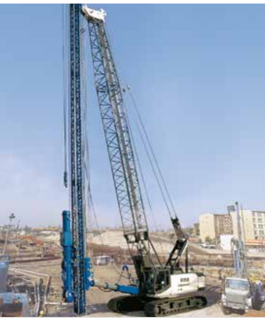
655 HD - With leader and piling hammer 655 HD - Mit Mäkler und Ramme
