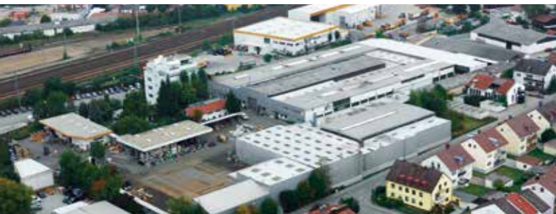
Works 1, Straubing – company headquarter Werk 1, Straubing – Unternehmenssitz
