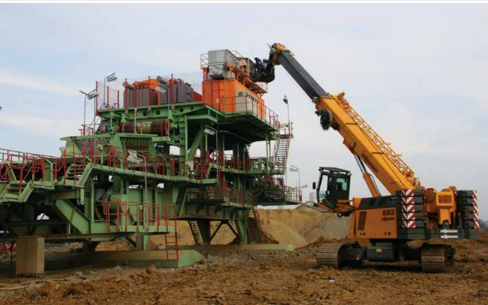
683 R – Installations- und Inspektionsarbeiten mit Arbeitsbühne im Tagebau; Serbia 683 R – Installations- und Inspektionsarbeiten mit Arbeitsbühne im Tagebau; Serbien
