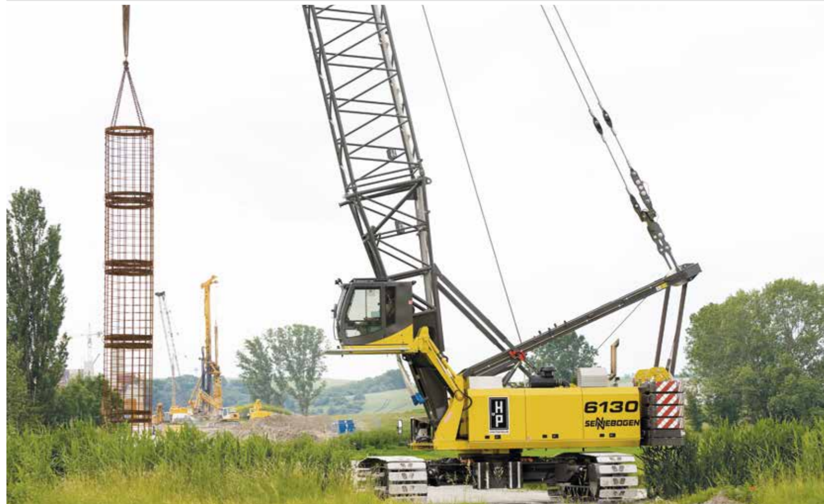
6130 HD – Foundation works; Germany 6130 HD - Grundierungsarbeiten; Deutschland
