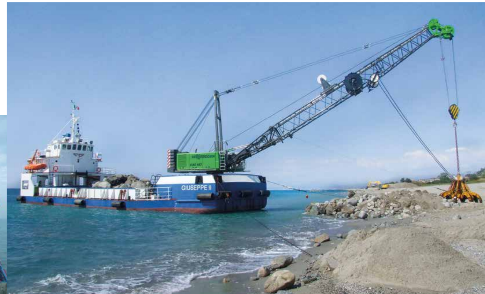
690 HD – Grab operation – Recreation of shorelines – Construction of wave-breakers; Italy 690 HD – Greifereinsatz – Wiederaufbau von Küsten – Bau von Wellenbrechern; Italien
