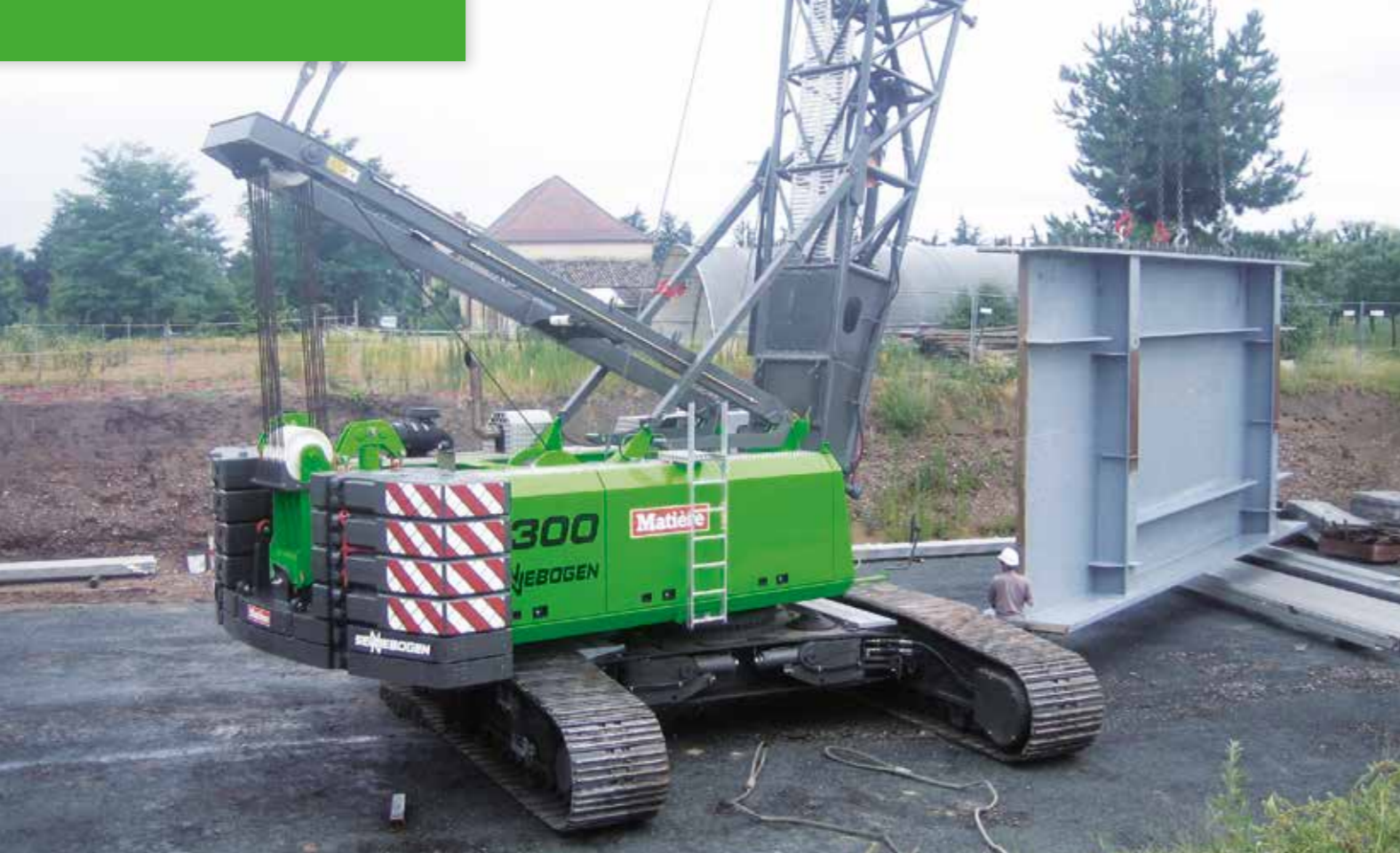
3300 – Setting of prefabricated bridge parts; France 3300 – Setzen von Fertigteil-Brückenelementen; Frankreich
