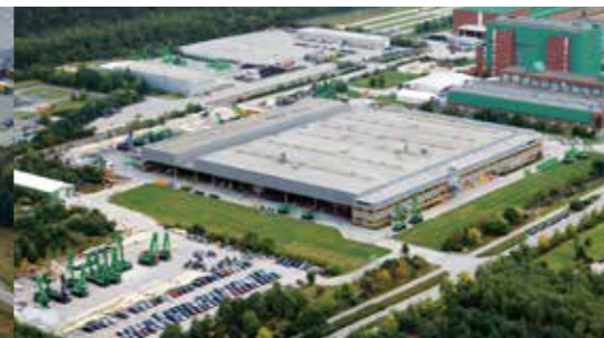
Works Wackersdorf – production Green Line series machines Werk Wackersdorf – Produktion Green Line Seriengeräte
