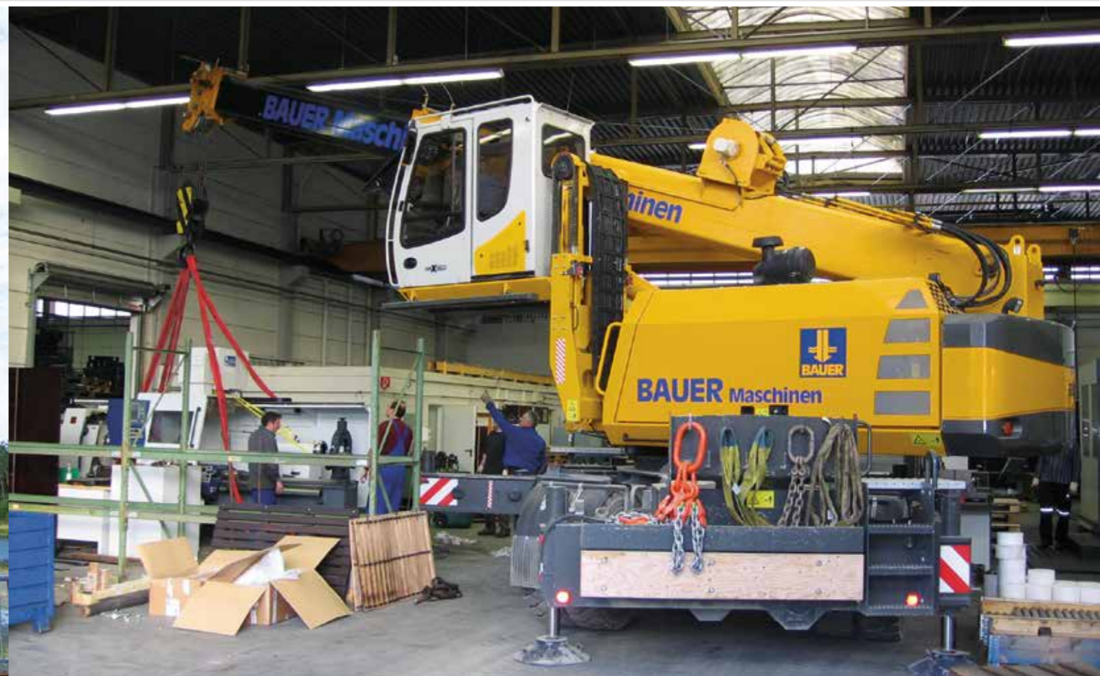
643 MI – Hoisting works for industrial assemblies and installations; Germany 643 MI – Hebearbeiten für industrielle Montagen und Installationen; Deutschland
