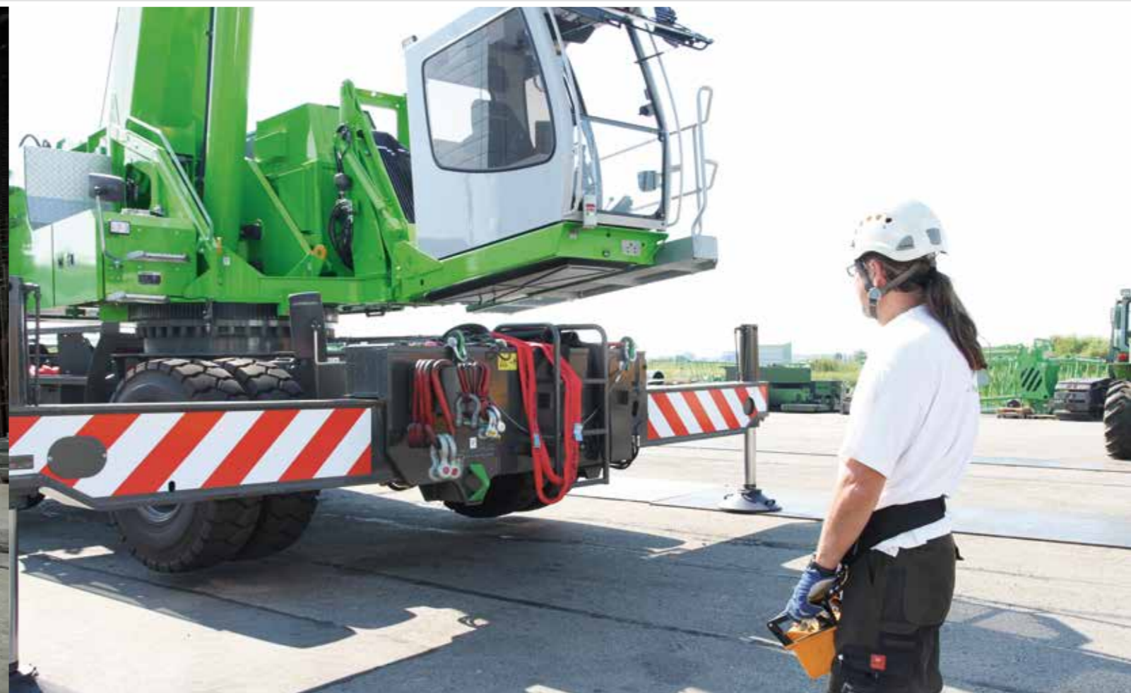
683 M – Crane operation via remote control; Germany 683 M – Kranarbeiten per Funkfernbedienung; Deutschland
