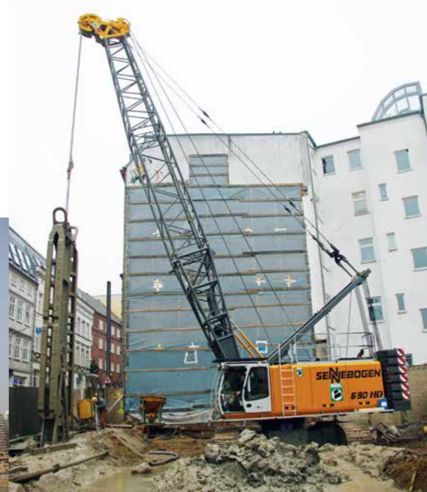
690 HD - With mechanical Stein-diaphragm wall grab; Germany 690 HD - Mit mechanischem Stein-Schlitzwandgreifer; Deutschland
