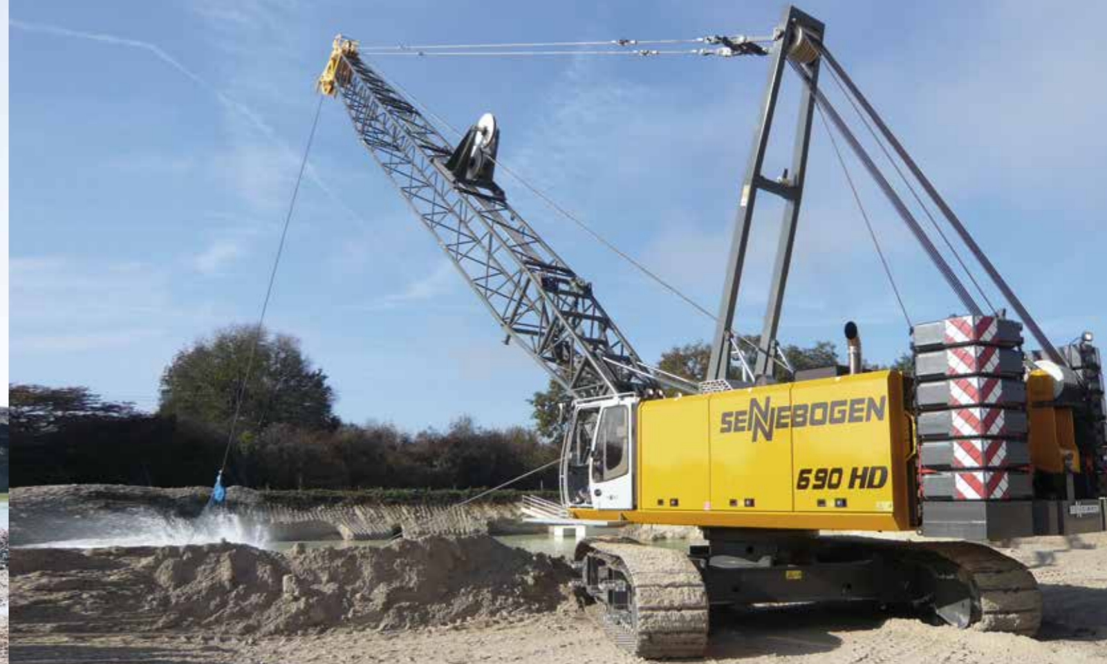
690 HD – Dragline operation with 4 cubic yards bucket; France 690 HD – Schleppschaufeleinsatz mit 3 m³ Schaufel; Frankreich
