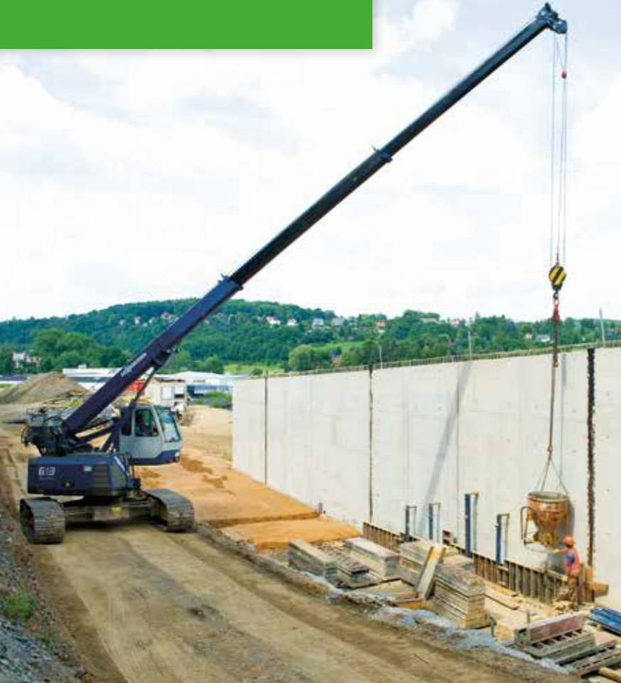
613 R – Lifting breasting boards – Cementation works on construction site; Germany 613 R – Einheben von Verschaltungstafeln – Zementierungsarbeiten auf Baustelle; Deutschland
