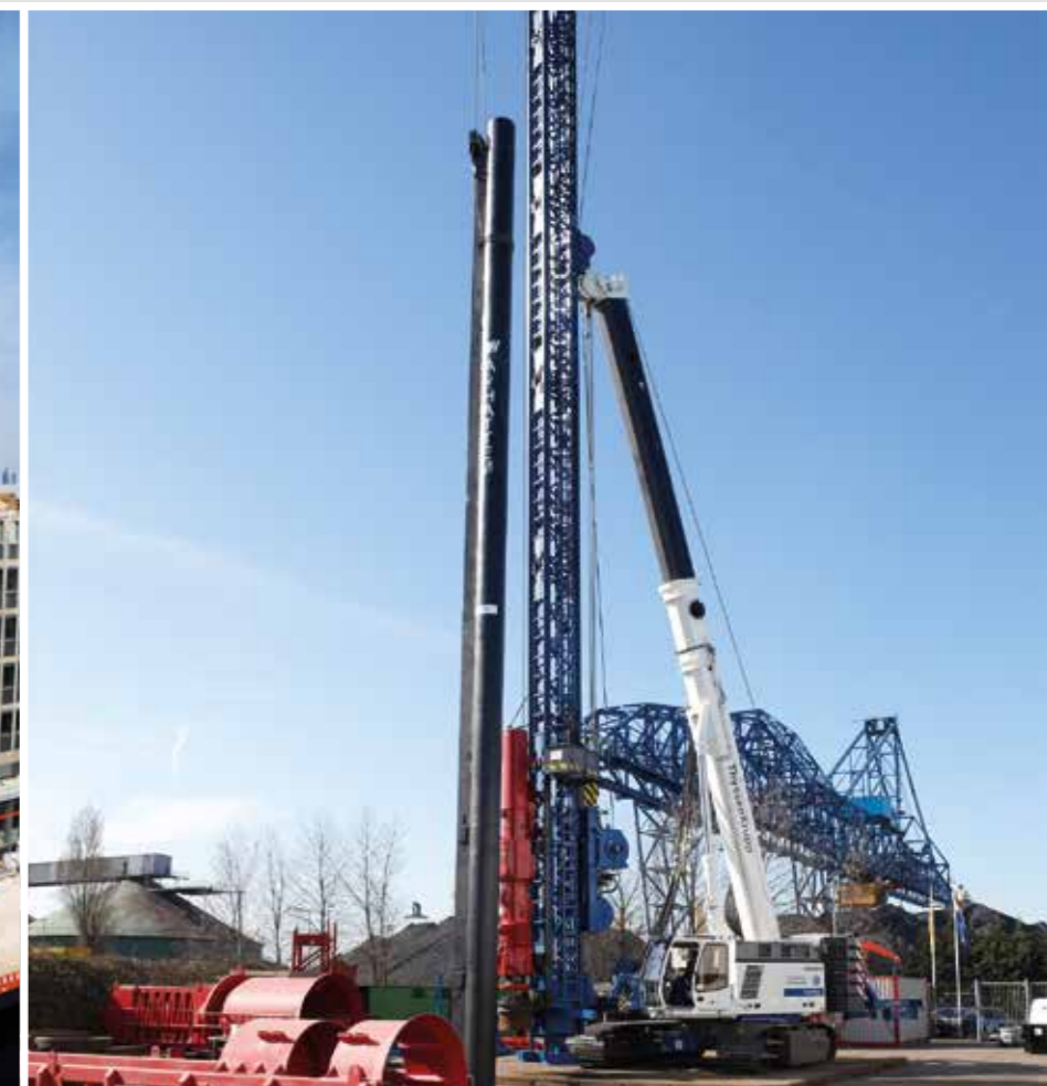
683 TP – Telescopic crawler crane with pile driver; Netherlands 683 TP – Raupenteleskopkran mit Mäkleranbau; Niederlande
