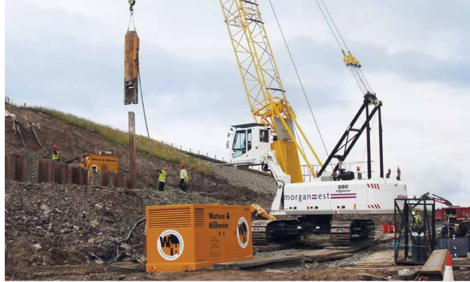
680 HD - Piling; Great Britain 680 HD - Rammeinsatz; Großbritannien
