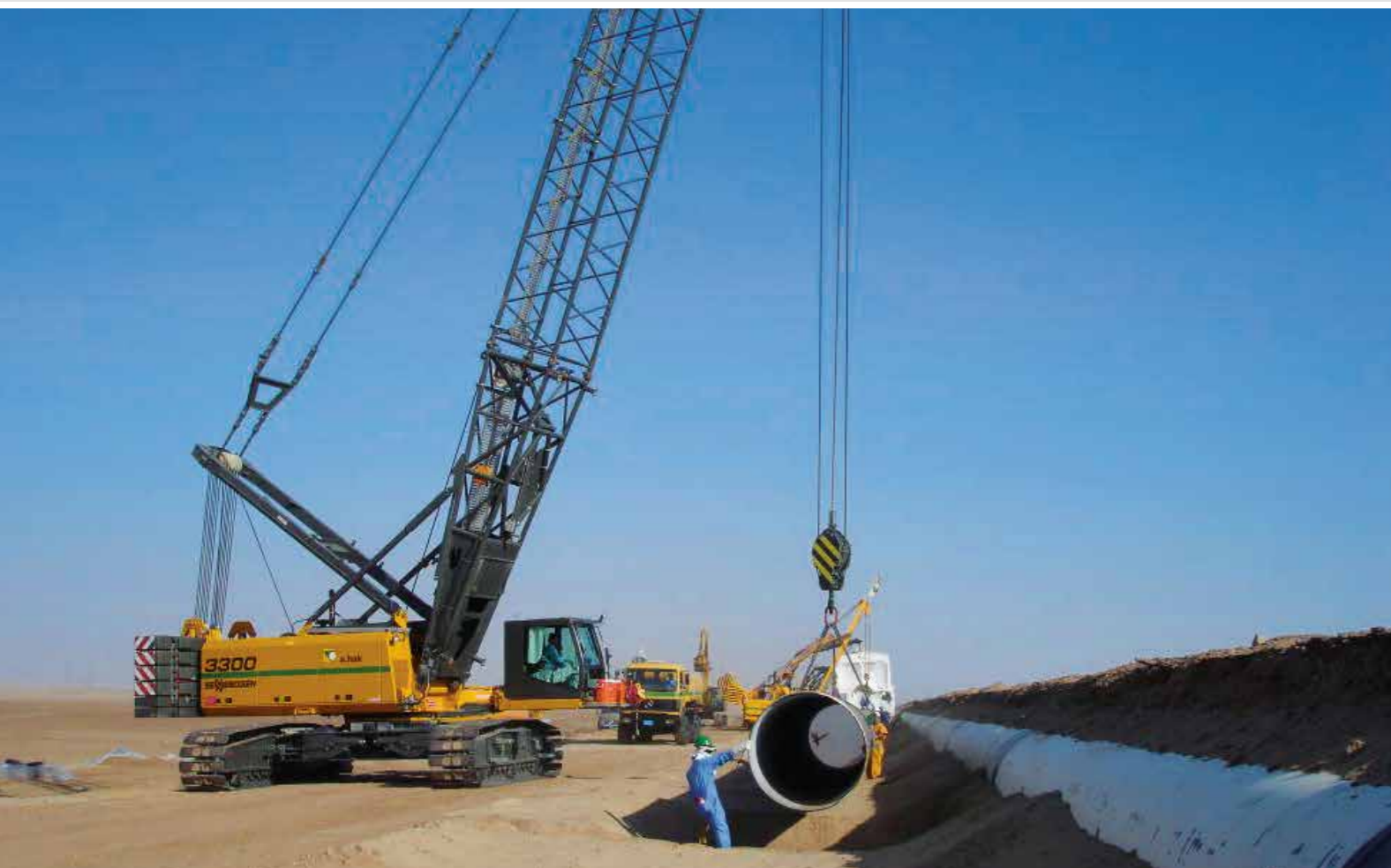
3300 - Positioning of tubes for pipeline construction with main boom; Saudi Arabia 3300 - Positionierung von Rohren beim Pipeline-Bau mit Hauptausleger; Saudi Arabien
