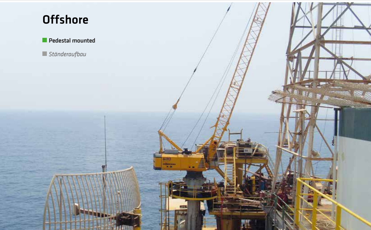
630 HD – Mounted on oil platform hoisting works for offshore application; Iran 630 HD – Hebearbeiten auf Offshore Ölplattform; Iran
