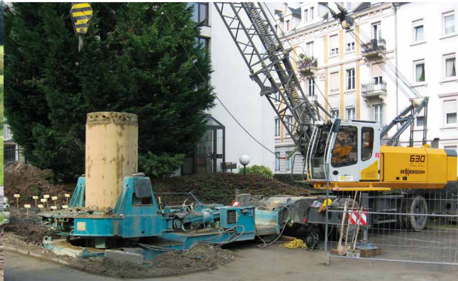
630 M – With additional on board hydraulics to drive a casing oscillator; France 630 M – Mit hydraulischem Zusatzpaket zum Betreiben der Verrohrungsmaschine; Frankreich
