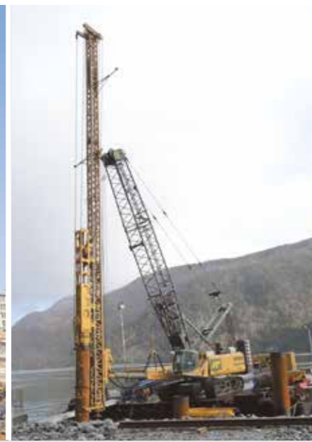
6100 HD - With leader and piling hammer 6100 HD - Mit Mäkler und Ramme
