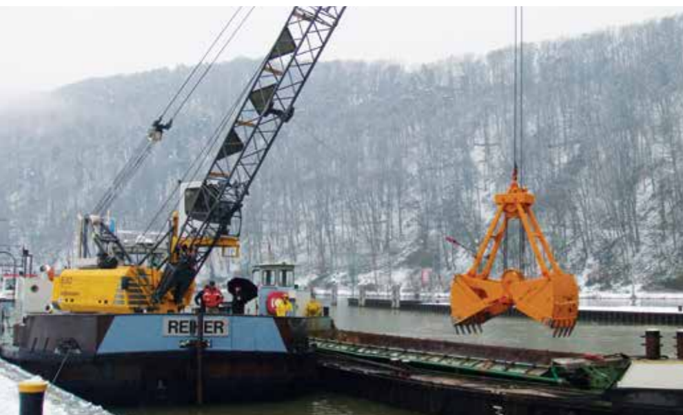
630 HD – Hydro construction works with underwater grab operation; Germany 630 HD – Wasserbau mit Greifereinsatz unterwasser; Deutschland
