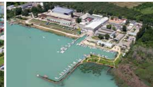
Works Balantonfüred/Hungary – welding/steel construction Werk Balantonfüred/Ungarn – Schweiß-/Stahlbaugruppen
