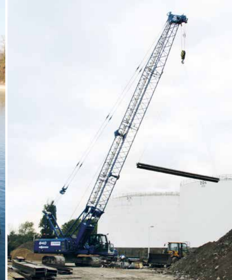
640 HD – Hoisting operation; Germany 640 HD – Hebeeinsatz; Deutschland
