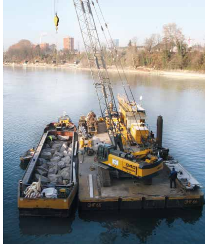
640 HD – Rock hoisting operation in hydro construction; Germany 640 HD – Stein-Hebeeinsatz im Wasserbau; Deutschland
