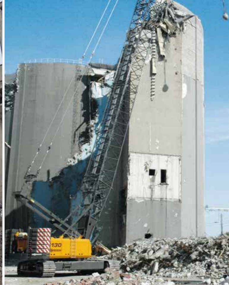
6130 HD – Demolition works with wrecking ball; Netherlands 6130 HD – Einsatz mit Abrissbirne; Niederlande
